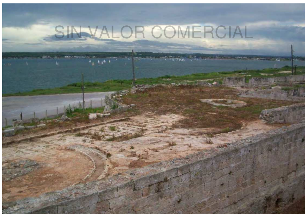
Figura 5. Arriba: foto histórica (1910-1930) de la Plataforma de San Juan donde se observan las cureñas móviles. Fuente: Colección digital de la Universidad de Miami. Abajo: Otra vista de la plataforma y la localización del basamento de las cureñas instaladas (2005-2006). Foto de los autores
